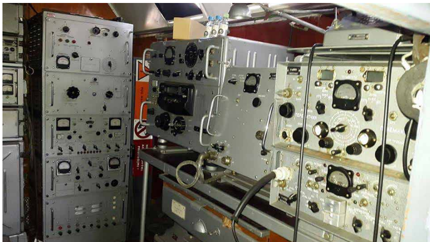
Wnętrze wozu odbiorczego radiostacji R-110 (od lewej: odbiornik Beryl-2, odbiornik R-250M, radiolinia R-403M)
