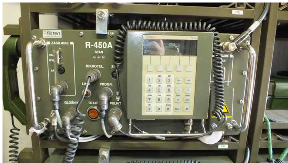
Radiolinia R-450A zamontowana w aparatuwni RWŁC-10/T
