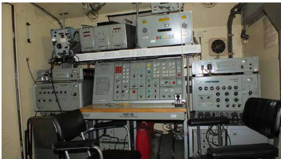
Wnętrze radiostacji R-161AP
