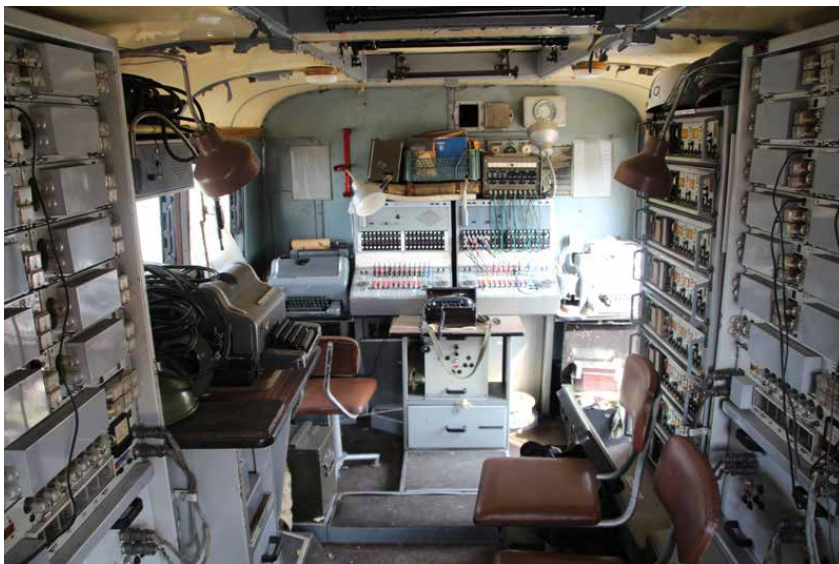
Wnętrze centrali telegraficznej CTgD-80
