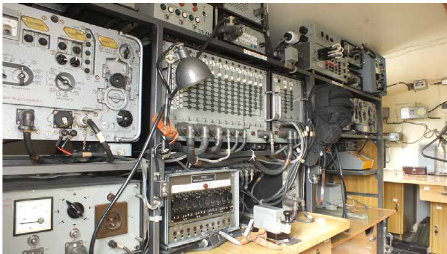
Wnętrze aparatowni ADK-11
