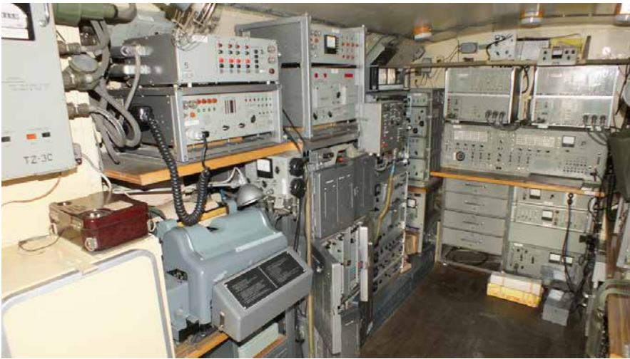
Wnętrze aparatuwni ARO-KU10
