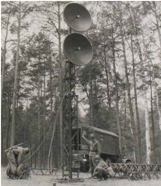
Stawianie masztu radiolinii R-404
