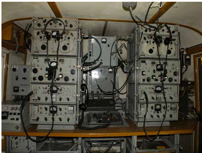
Półkomplety radiolinii R-405Z wewnątrz aparatuwni RWŁ-1M
