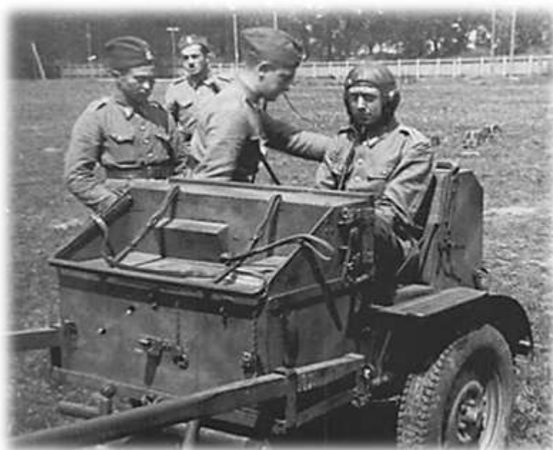
Radiostacja N2B, przenoszona na jednoosiowej biedce.
