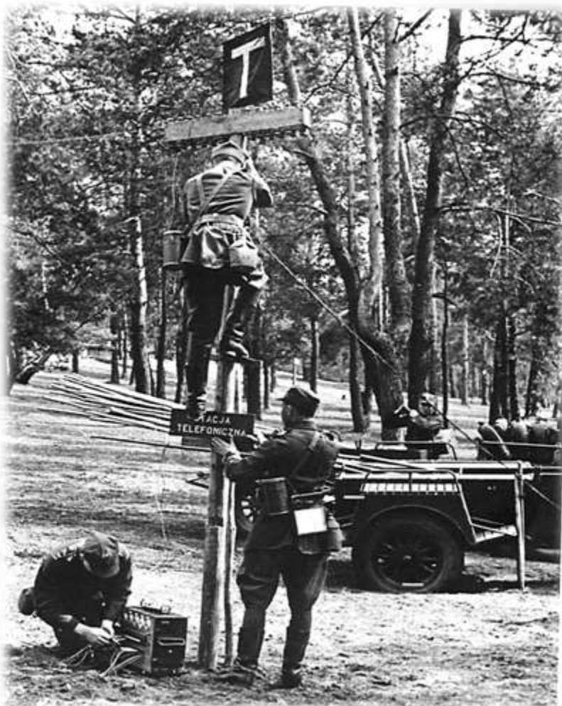
Patrol telefoniczny podczas montażu stacji telefonicznej. Na szczycie słupa zamocowana flaga stacyjna, pod spodem do poprzeczki przybite izolatoriki drewniane, do których zamocowano kable linii telefonicznych, podłączone do łącznicy ŁP10-28, stojącej obok słupa; w tle widoczny wóz telefoniczny drużynowy wz. 37ł. Źródło zdjęć: P. Krzysztofik, Pomocnicze środki łączności...
