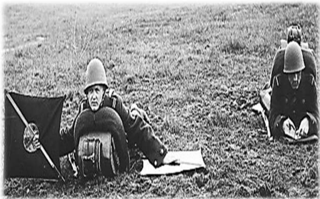
Stacja sygnalizacji ręcznej z tarczami do przekazywania krótkich meldunków za pomocą Morse'a lub innych, umówionych sygnałów.
