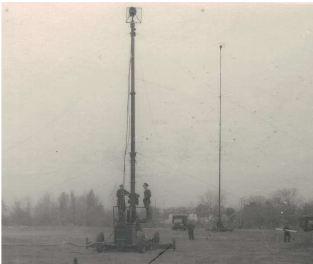
Rozwijanie radiolinii RVG-902C
