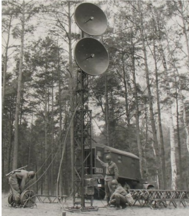
Stawianie masztu radiolinii R-404
