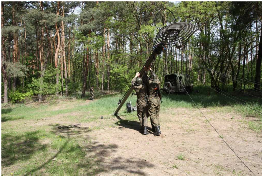
Stawianie masztu radioliniowego w aparatuwni RWŁC-10/T
